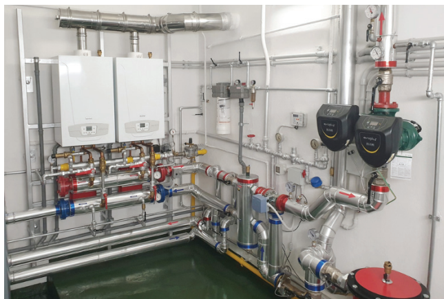
Rys. 3. Przykładowy fragment kotłowni wyposażonej w dwa współpracujące kotły gazowe typu Luna Duo-Tec MP+ firmy BAXI – De Dietrich obejmujący widok obiegu kotłowego [39] Fig. 3. An example of a boiler room equipped with two Luna Duo-Tec MP+ gas boilers from BAXI – De Dietrich, showing the boiler circuit [39]
