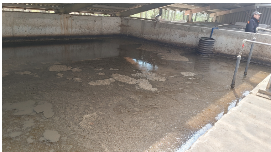
Rys. 3. Komora tlenowej stabilizacji osadu podczas prac badawczych Fig. 3. Aerobic sludge stabilization chamber during experimental work
