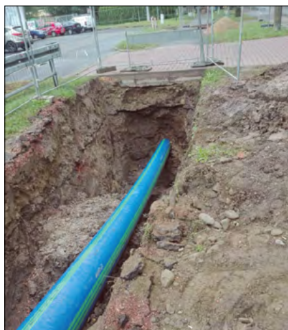
Fot. 1. Wymiana wodociągu AC 350 mm na PEHD 400 mm
