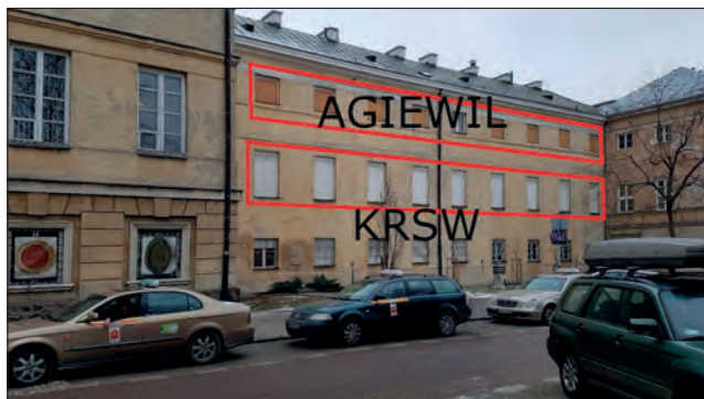
Rys. 1. Budynek AGAD, skrzydło od ul. Kilińskiego – lokalizacja magazynów AGIEWIL i KRSW (zdj. Piotr Narowski) Fig. 1. AGAD building, wing from Kiliński Street – location of AGIEWIL and KRSW warehouses (photo: Piotr Narowski)
