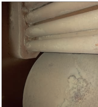
Fot. 1 Zanieczyszczone kamieniem kotłowym płomieniówki i płomienica kotła parowego
