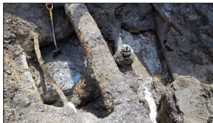
Fot. 6. Trójnik zasuw przygotowany do wymiany (nad trójnikiem i obok widoczne przewody kanalizacji deszczowej, widoczne również są kable teletechniczne w rurach osłonowych) Pic. 6. Gate valve tee prepared for replacement (above the tee and next to it there are visible rainwater drainage pipes, teletechnical cables in casing pipes)
