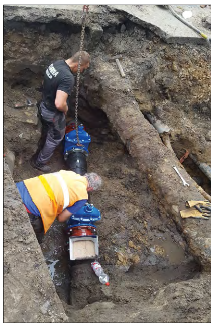
Fot. 7. Kolejny etap wymiany trójnika zasuw Pic. 7. Next stage of replacement works
