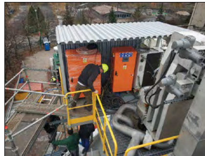
Rys. 10 Montaż kotła odzysknicowego (u góry); montaż szaf sterowniczych i palnika plazmowego oraz palnika biomasowego z kanałami dolotowymi i przepustnicami (na dole)
