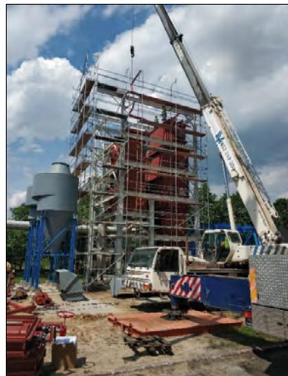
Rys. 11 Komora paleniskowa w budowie (u góry) i kocioł hybrydowy gotowy do testów (na dole)
