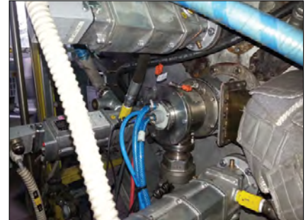
Rys. 3 Zapalarka plazmowa (u góry) oraz palnik biomasy z zapalarką plazmową na stanowisku badawczym 0,5MW (na dole)
