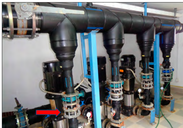
Rys. 1. Zdjęcie pompowni wody surowej (2018)
