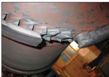
Rys.1. Uszkodzenia koła regulacyjnego w trakcie pierwszej awarii Fig.1. Damage to the control stage during the first failure
