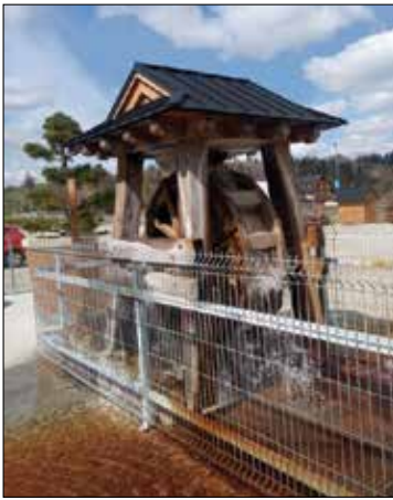
Ryc. 4. Urządzenia schładzające – napowietrzające zużyte wody termalne [źródło: własne] Fig. 4. Cooling and aerating devices for used thermal waters [own source]
