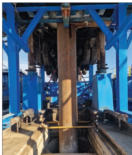
Rys. 5. Widok rury obsadowej Fig. 5. View of the manning pipe
