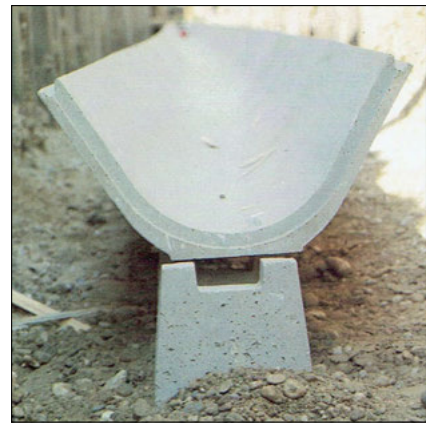
Rys. 2. Polimerobetonowe podpórki szalunków układane na dnie wykopu [1] Fig. 2. Polymer concrete formwork supports placed on the bottom of the trench [1]
