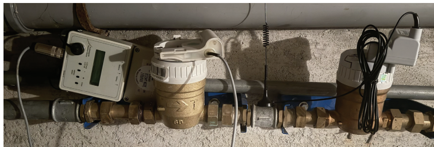
Rys. 1. Widok wodomierzy z podłączonymi rejestratorami Fig. 1. View of the water meters with connected recorders
