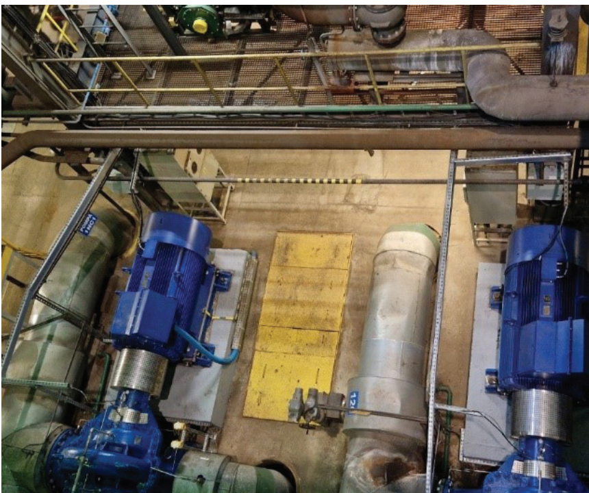
Rys. 10. Widok z góry pomp wstępnych NC po modernizacji (źródło: fotografia własna) Fig. 10. Top view of the NC booster pumps after modernization (source: author's photo)
