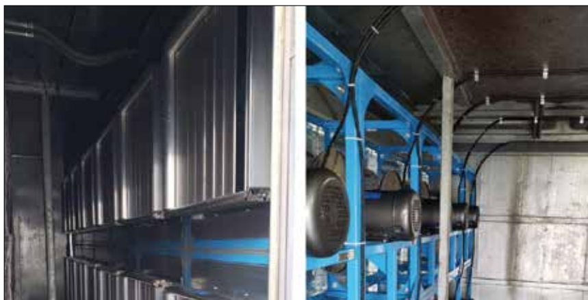
(a) (b) Rys. 2. Zespół wentylatorów IntelliCUBE firmy Mainstream Fluid & Air LLC [7], a) widok od strony ssawnej, b) widok od strony tłocznej Fig. 2. The IntelliCUBE Mainstream Fluid & Air LLC fan array [7], a) suction side, b) discharge side
