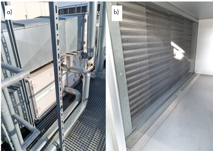
Rys. 3. Kieszeniowy filtr powietrza - powierzchnia boczna (a) i powierzchnia filtracyjna (b) Fig. 3. Pocket air filter – side surface (a) and filtration surface (b)
