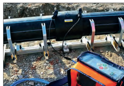
Rys. 8. Centrownik do wykonywania połączeń zgrzewanych fot. www.zabtr.ru
