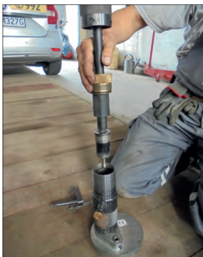
Rys. 2. Urządzenie do wiercenia TDW, fot. autora
