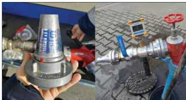
Rys. 3. Montaż dyszy pomiarowej oraz elektronicznego testera hydrantów Fig. 3. Mounting of measuring nozzle and electronic hydrant tester
