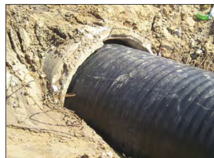
Rys. 2. Wolna przestrzeń międzyrurowa wypełniana specjalną zaprawą cementową (zdjęcie własne) Fig. 2. The free space between the pipes which is filled with a special cement mortar (own photo)
