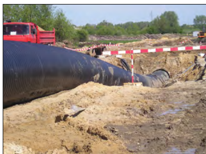
Rys. 1. Wciąganie rury polietylenowej Weholite-Spiro DN1500 do wnętrza rury żelbetowej o średnicy wewnętrznej 1800 mm (zdjęcie własne) Fig. 1. Inserting the Weholite-Spiro DN1500 polyethylene pipe into the reinforced concrete pipe with an internal diameter of 1800 mm (own photo)
